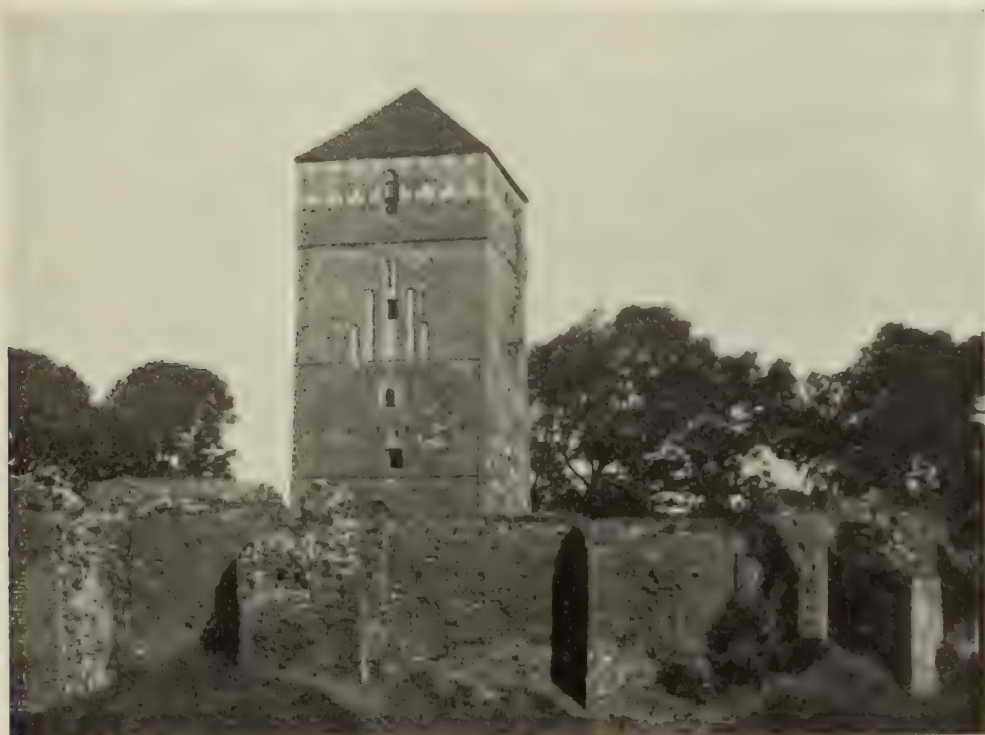
Fig. 332. Wittstock. Ansicht der Burg mit dem sog. Amtsturm.
